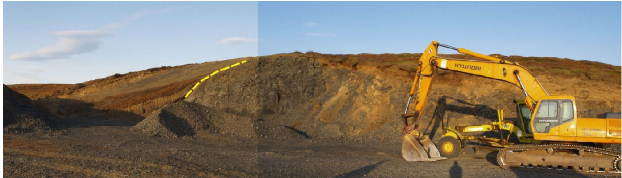
Mynd 26 Efnistökusvæði ÞRN-2.
