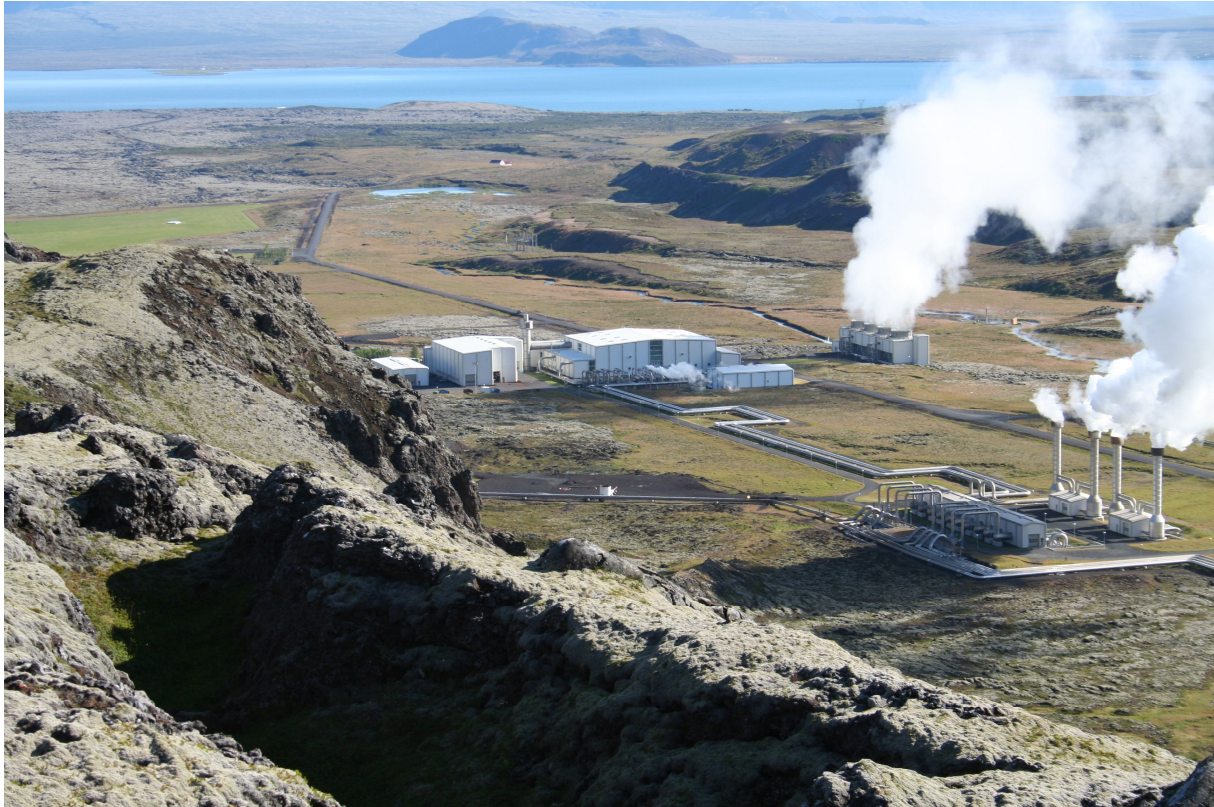
Mynd 18 Skiljustöðvar, aðveituæðar, stöðvarhúsmannvirki og kæliturn á Nesjavöllum.
