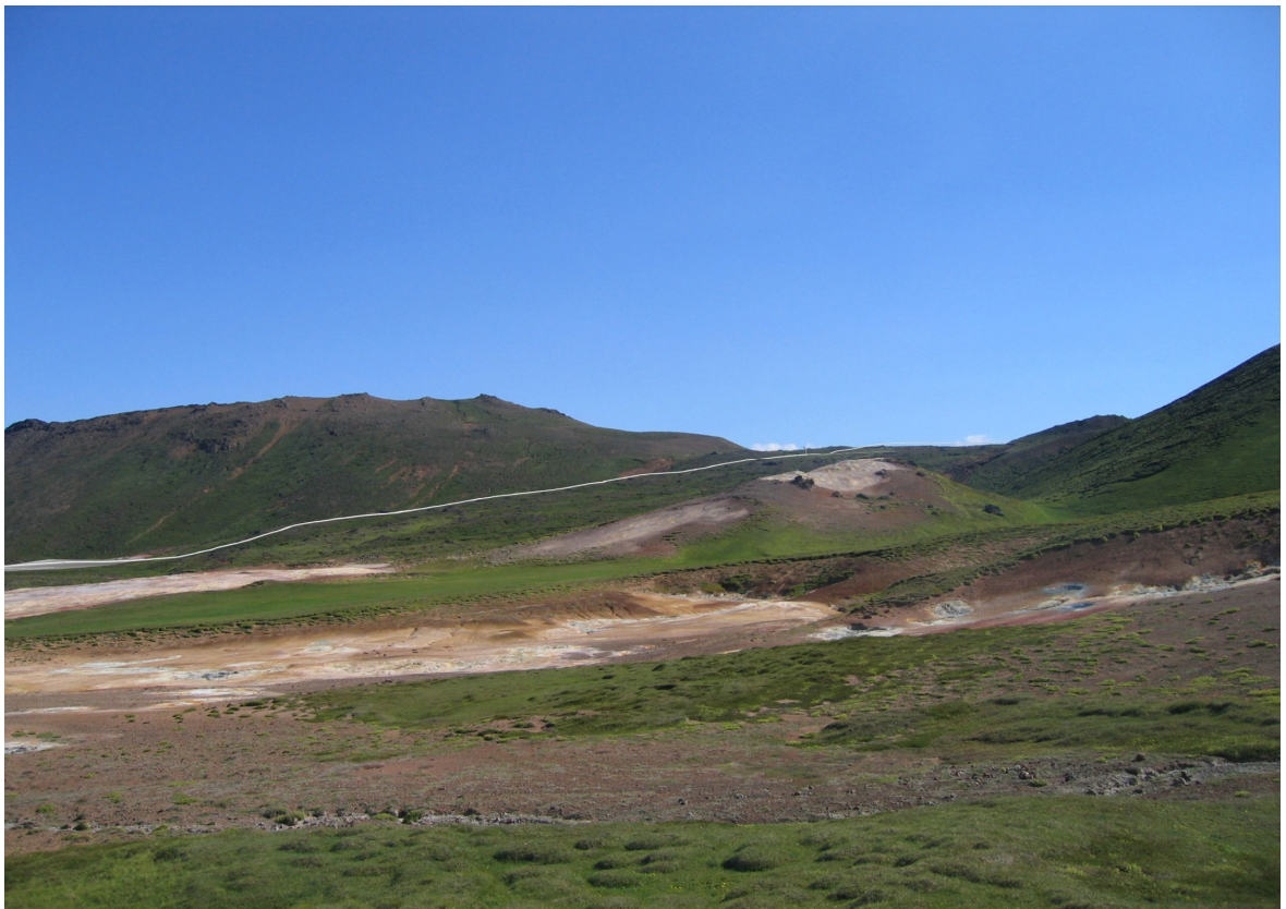
Mynd 109 Mynd tekin í átt að Bóndhólsskarði skammt suðaustur af skálanum á Þeistareykjum. Safnæðalögn frá borsvæðum ofan skarðsins hefur verið sett inn á myndina.
