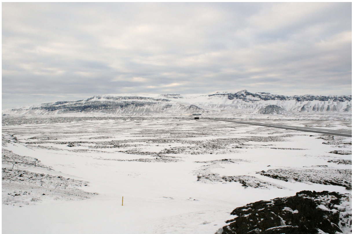
Mynd 111 Horft af virkjunarvegi til suðvesturs í átt að borsvæði O. Á miðri myndinni má sjá skiljustöð sem áformuð er við hlið þess. Aðkomuvegur og lagnir hafa verið sett hægra megin inn á myndina.
